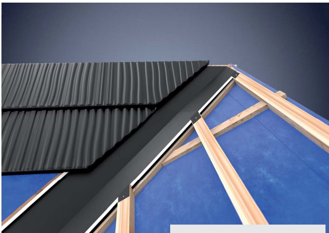
Následně se montuje horní sada šablon.
