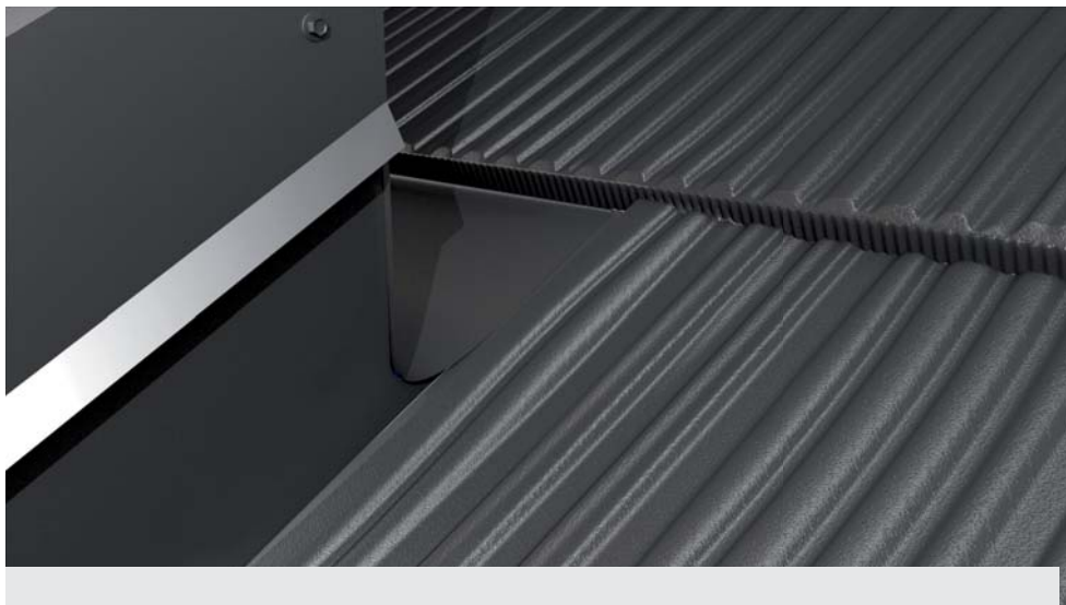
Zadní část lemování komínu po montáži krytiny.
