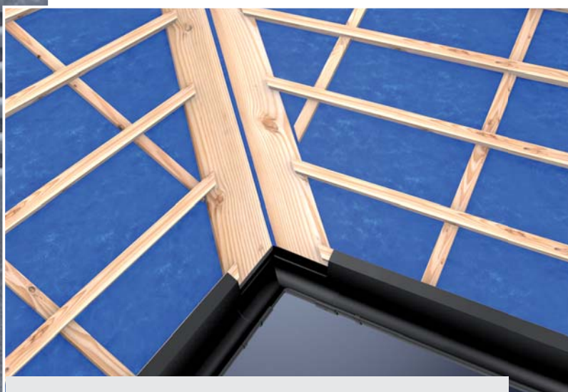
Příprava pod úžlabním plechem.
