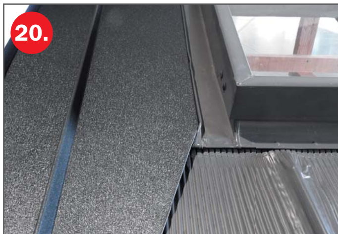
20. Nutná je přesnost a preciznost. Vzdálenost hrany bočního dílu krytiny od stojaté drážky lemování je cca 2-3 mm.
