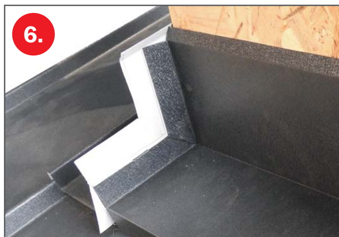
Sesazení spodního a bočních dílů lemování
