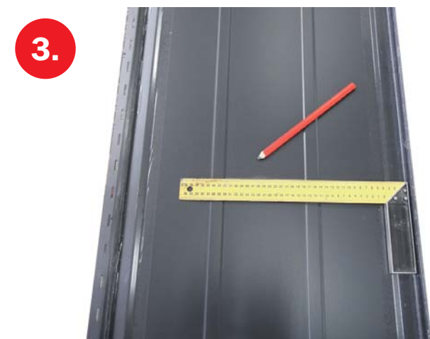
3. Ideální řešení je, aby prostup vycházel ve středu šířky pásu krytiny
