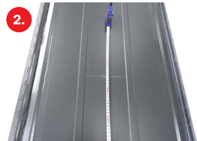
2. Místo otvoru v krytině je potřeba pečlivě vyměřit.
