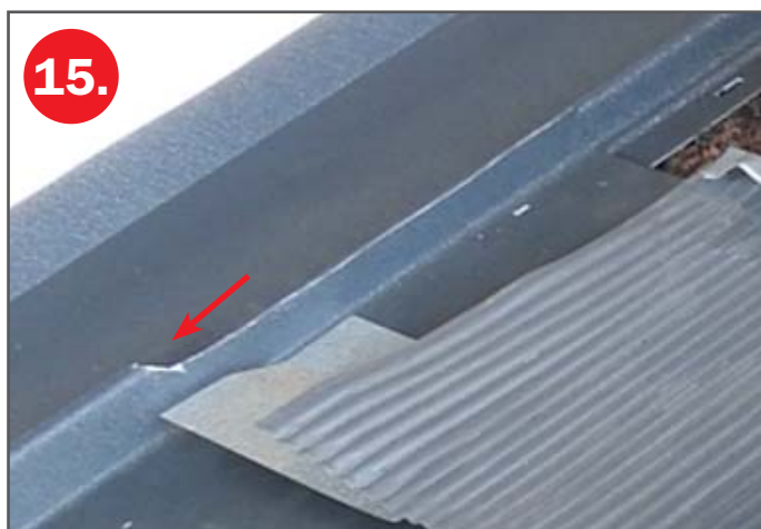
Po slícování bočního dílu krytiny je nutno odstříhnout část zámku krytiny.
