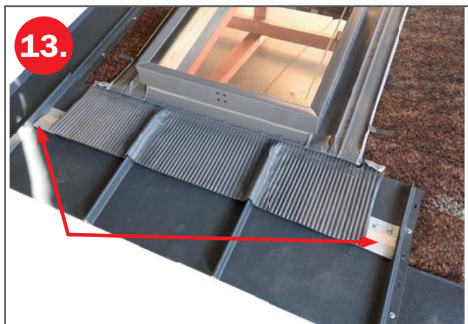
Osazení Spojovacího plechu Rapid (SPR) pro spolehlivé osazení bočních dílů krytiny
