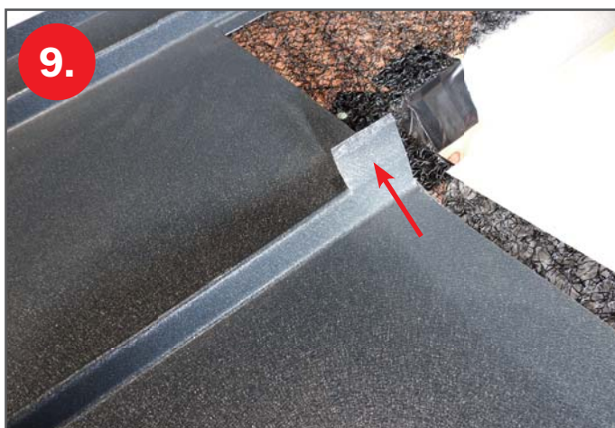
9. Příprava krytí na horním dílu zámku krytiny
