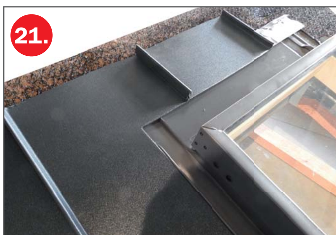
21. Osazení dílů krytiny nad oknem, na které se naváže boční díl krytiny na opačné straně výlezu.
