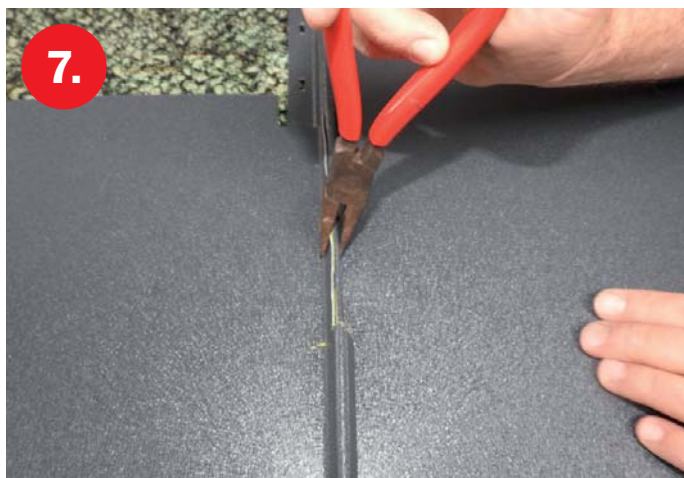
V místě vystřížení je potřeba zámek srovnat kleštěmi
