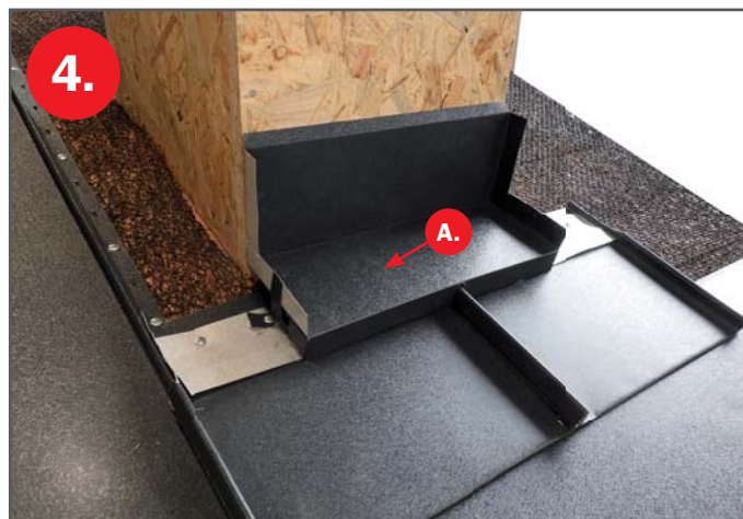
A. Spodního dílu lemování (atyp, nutno vyrobit dle rozměru komínu)
