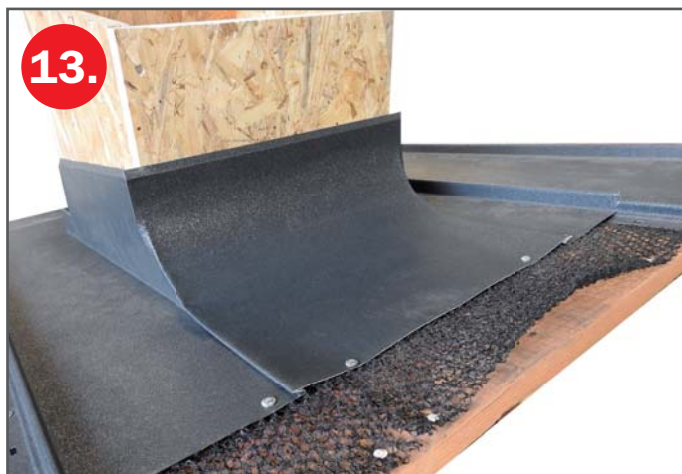
Sesazení zadního dílu lemování s díly bočními.
