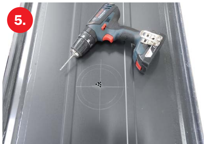
5. Ve středu odvrtáme, nebo prorazíme otvor
