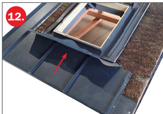
12. Před finálním osazením okna musí být na spodní stranu manžety aplikovaný butylkaučuková páska
