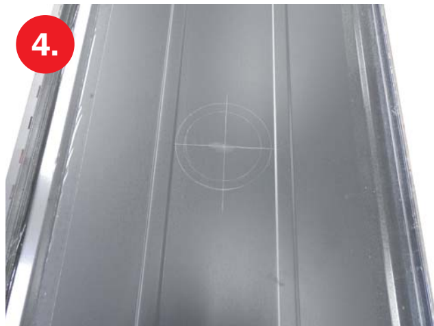
4. Nakreslíme průměr otvoru, musíme připočítat cca 5 mm na pertlík.
