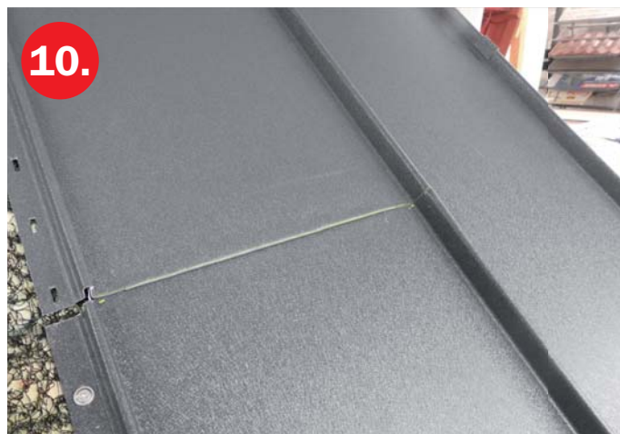
Do SPR se zasune ohnutý zástřih na horním dílu krytiny a tento díl se nacvakne do zámků.
